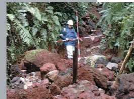
土石流・砂防調査
